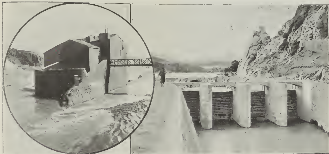
100 Vista de la presa y de la toma de aguas del canal de la derecha.—Compuertas y entrada del canal de la izquierda
